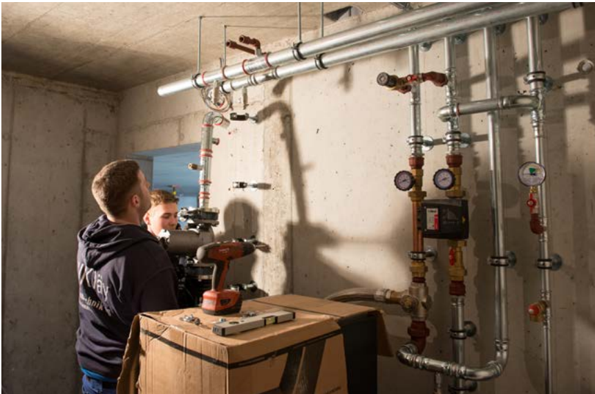
Installateure bei der Arbeit
